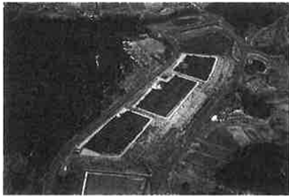
太陽光パネルが整然と配置されている木下第三発電所
