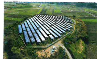
2017年、木下エネルギーパークが新しく取得した和歌山県御坊市にある太陽光発電所。
