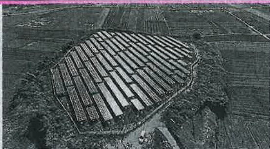
木下エネルギーパークが取得した和歌山県御坊市の太陽光発電所
