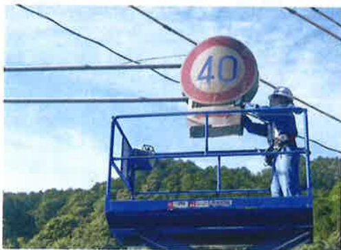
標識撤去工事
