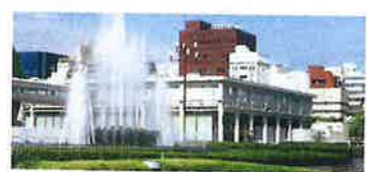
広島平和記念資料館東館耐震改修工事
