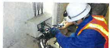
共同溝の配線接続工事
